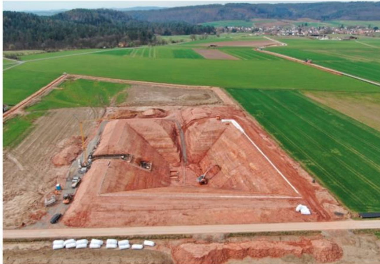
Construction du réservoir de chaleur en 2024. Source : solarwaerme-bracht.de
