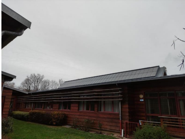
Installation n°2 : CESAME – Maison d'Accueil Spécialisée Port Thibault à Sainte-Gemmes-sur-Loire
